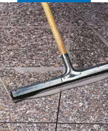
Spoinowanie wyrównanego i wypolerowanego granitu gumową rakłą
