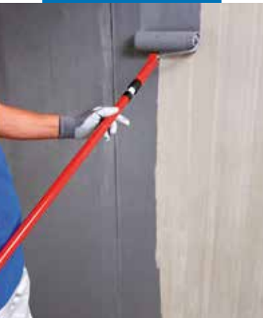
Nakładanie Eco Prim Grip wałkiem na powierzchnię betonową
